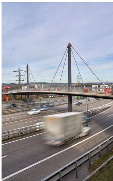
Die Seilkonstruktion ermöglichte den Bau einer relativ leichten Fahrbahn.
